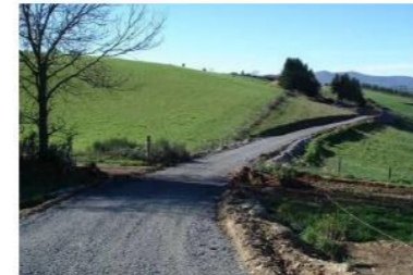
Mise en place du gravier
