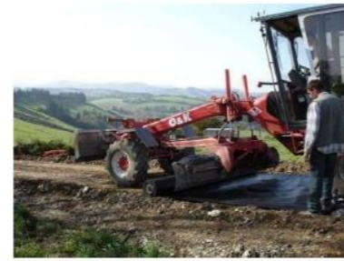
Pose du géotextile
