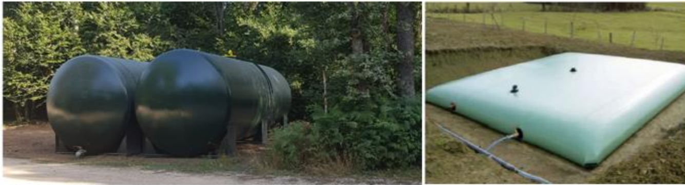
Figure 11 : Exemple de réserves d'eau artificielles métalliques (à gauche) et souple (à droite)
