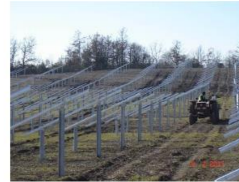
Figure 17 : Montage des structures porteuses
