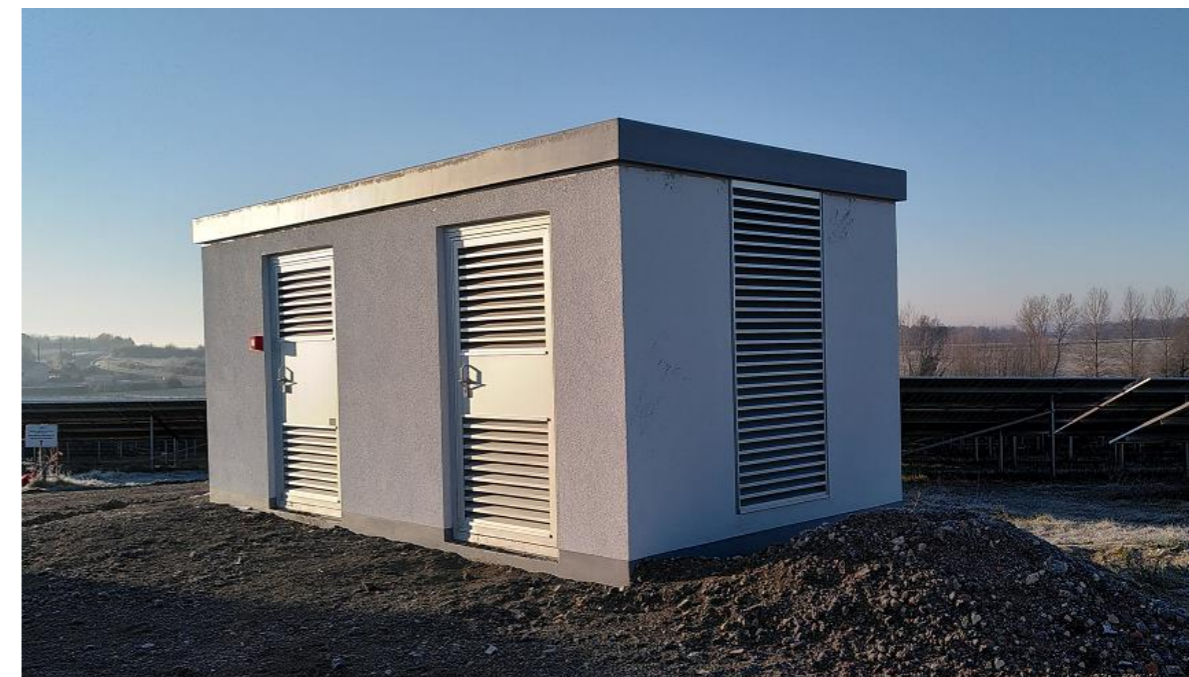
Figure 9 - Poste de transformation remblayé
