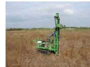
Sondage au pénétromètre
